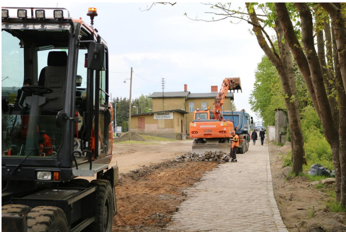
Fot. 28. Remont drogi do Banku w Będzinie, rozpoczęcie w 2020, zakończenie w 2021r. Źródło: Archiwum własne
