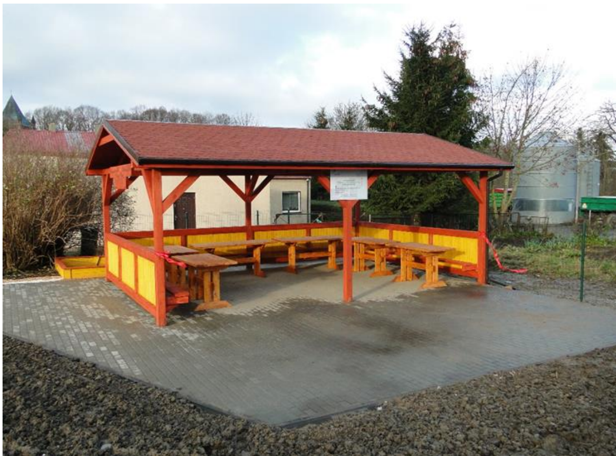
Fot. 5. Sołectwo Łekno w ramach grantów sołeckich wybudowało wiatę Źródło: Archiwum własne
