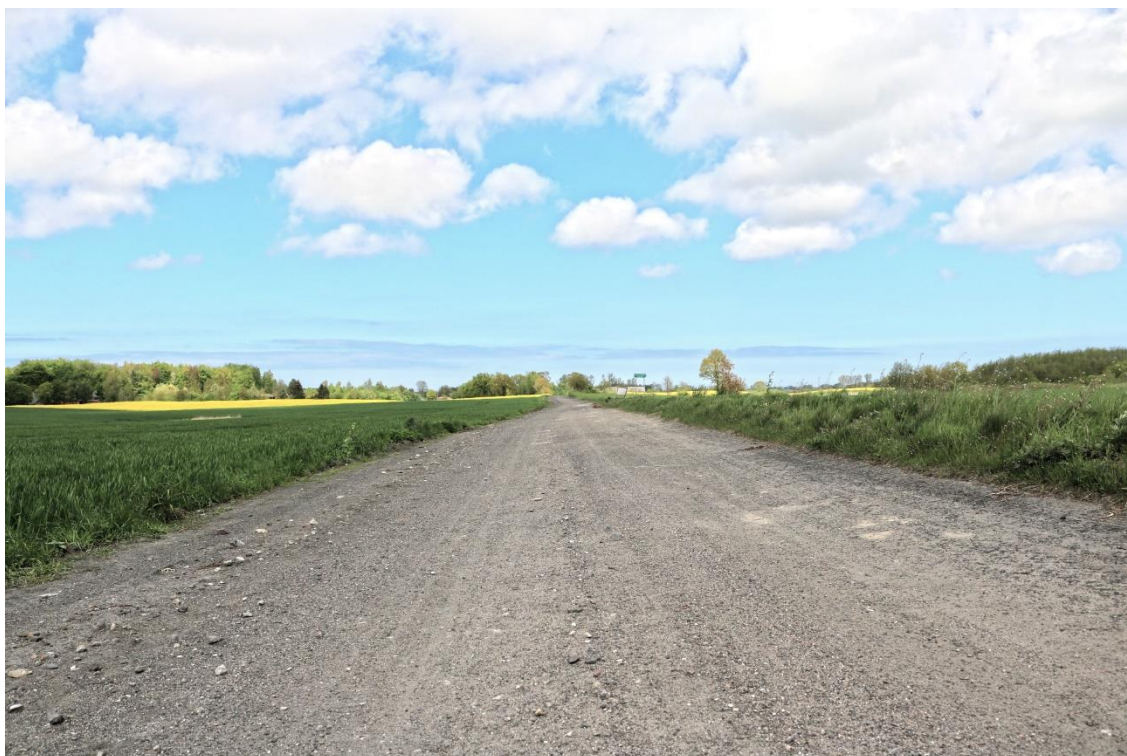
Fot. 27. Wyrównana powierzchnia drogi gminnej. Źródło: Archiwum własne
