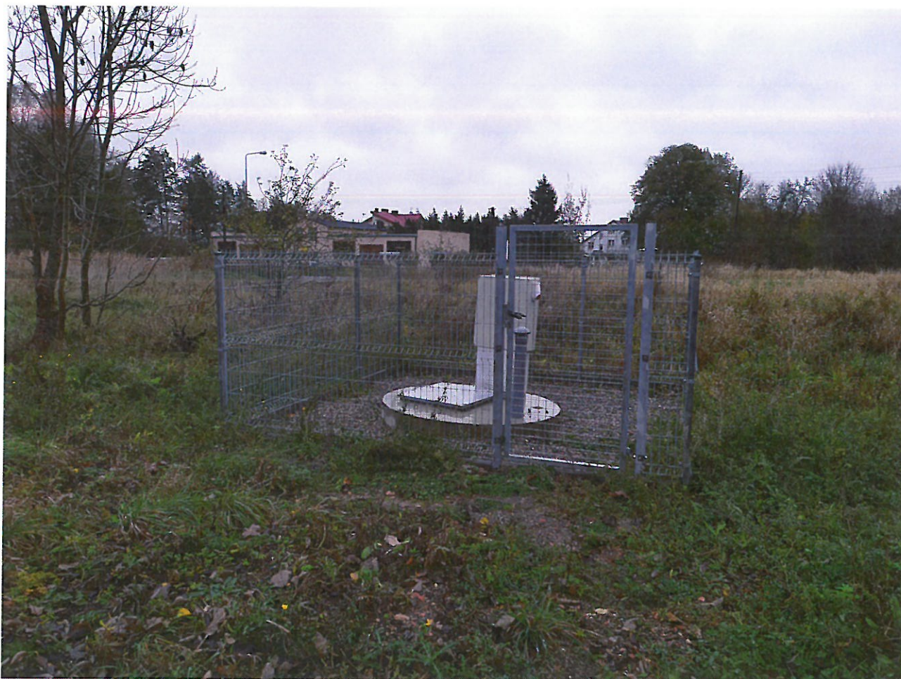
Zdj. 1. Istniejącej przepompowni ścieków na dz. nr 231/1 obr. Strzeżenice
